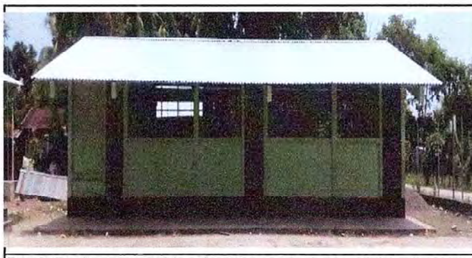
Foto 5: En ella se muestra la colocación completa del techado del modulo
