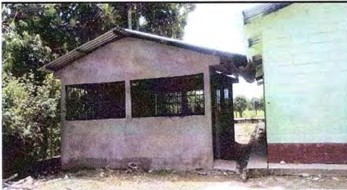
Foto 1: Rehabilitación de cocina
