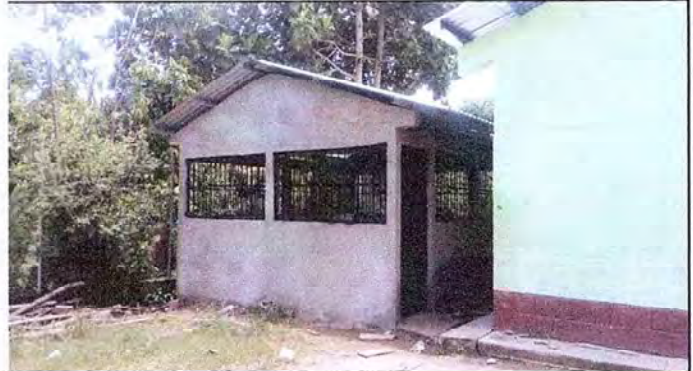
Foto 2: En ella se muestra la instalación de la puerta y los balcones colocados
