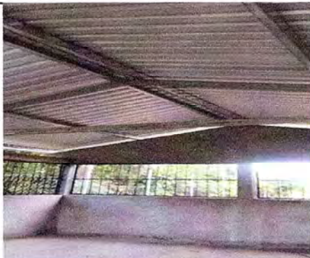
Foto 3: Del interior, se puede apreciar la estructura del entechado de la cocina.
