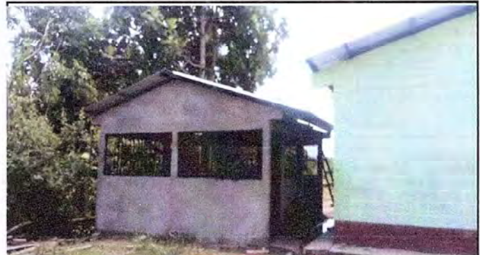
Foto 4: Vista frontal de la cocina culminada.
